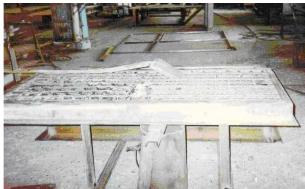
Рис. 1. Бронедверь 8 класса устойчивости к взлому ДХЦ - 8. Экспериментальный образец. Процесс заполнения бронекоробки сталефибробетонной смесью
